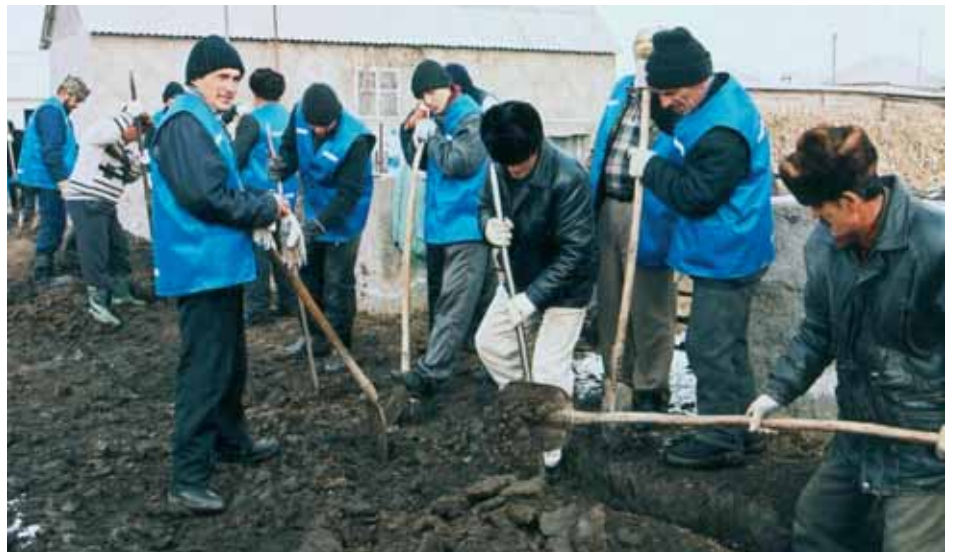
Прокладка траншеи для труб водоснабжения в селе Кантышево, Ингушетия
